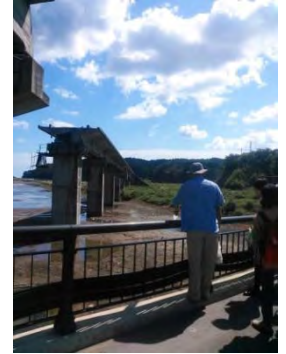
JR 気仙沼線の高架橋
